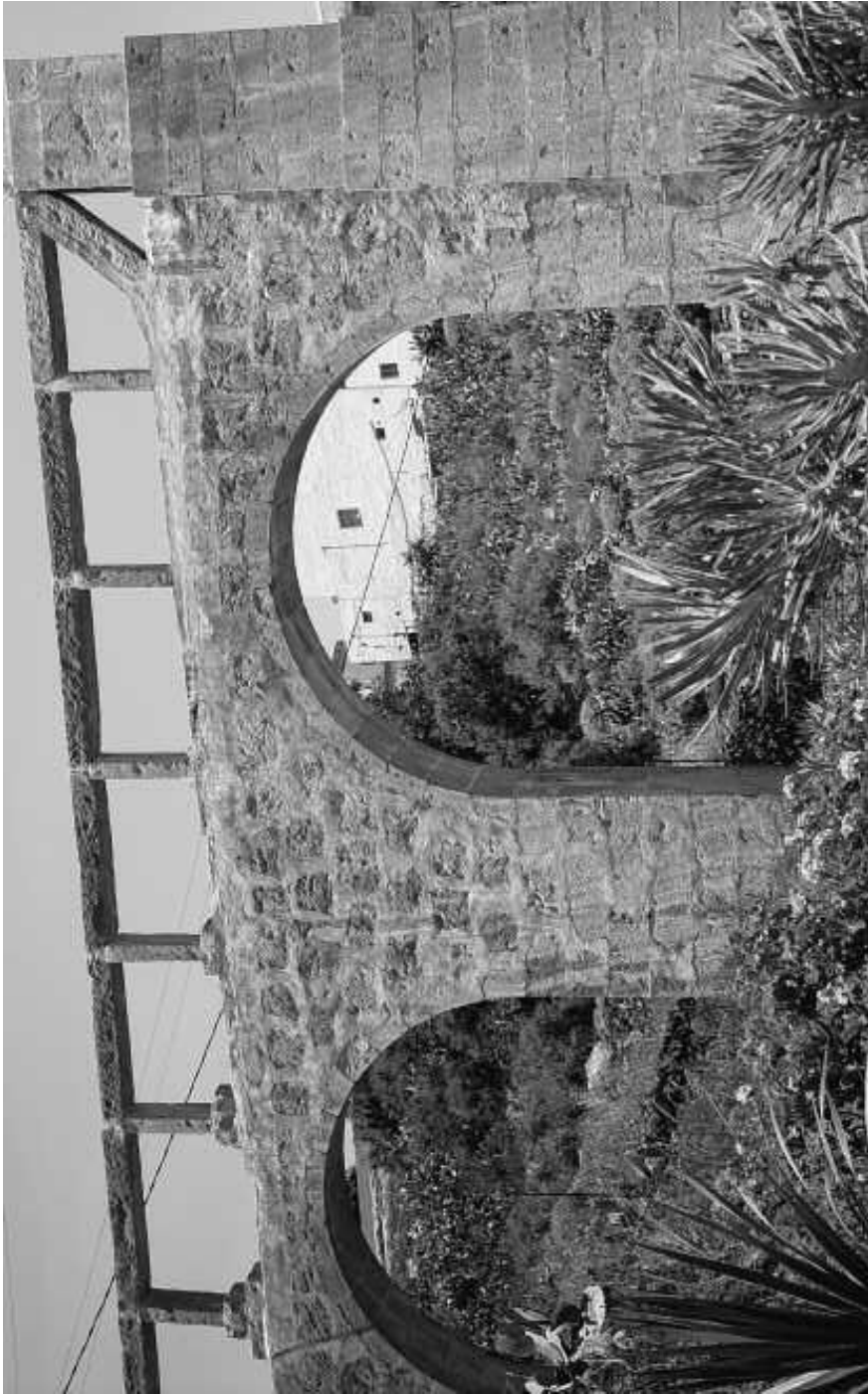
Acueducto con salto de agua para mover un molino de gofio.
