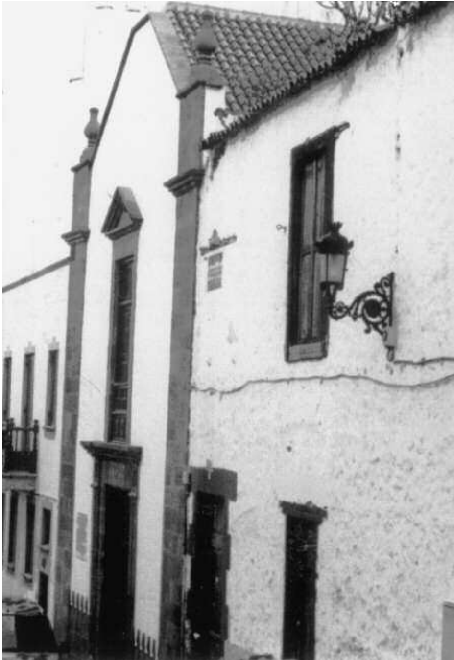
Iglesia y casa del Hospicio tal y como era desde su construcción en 1700.
