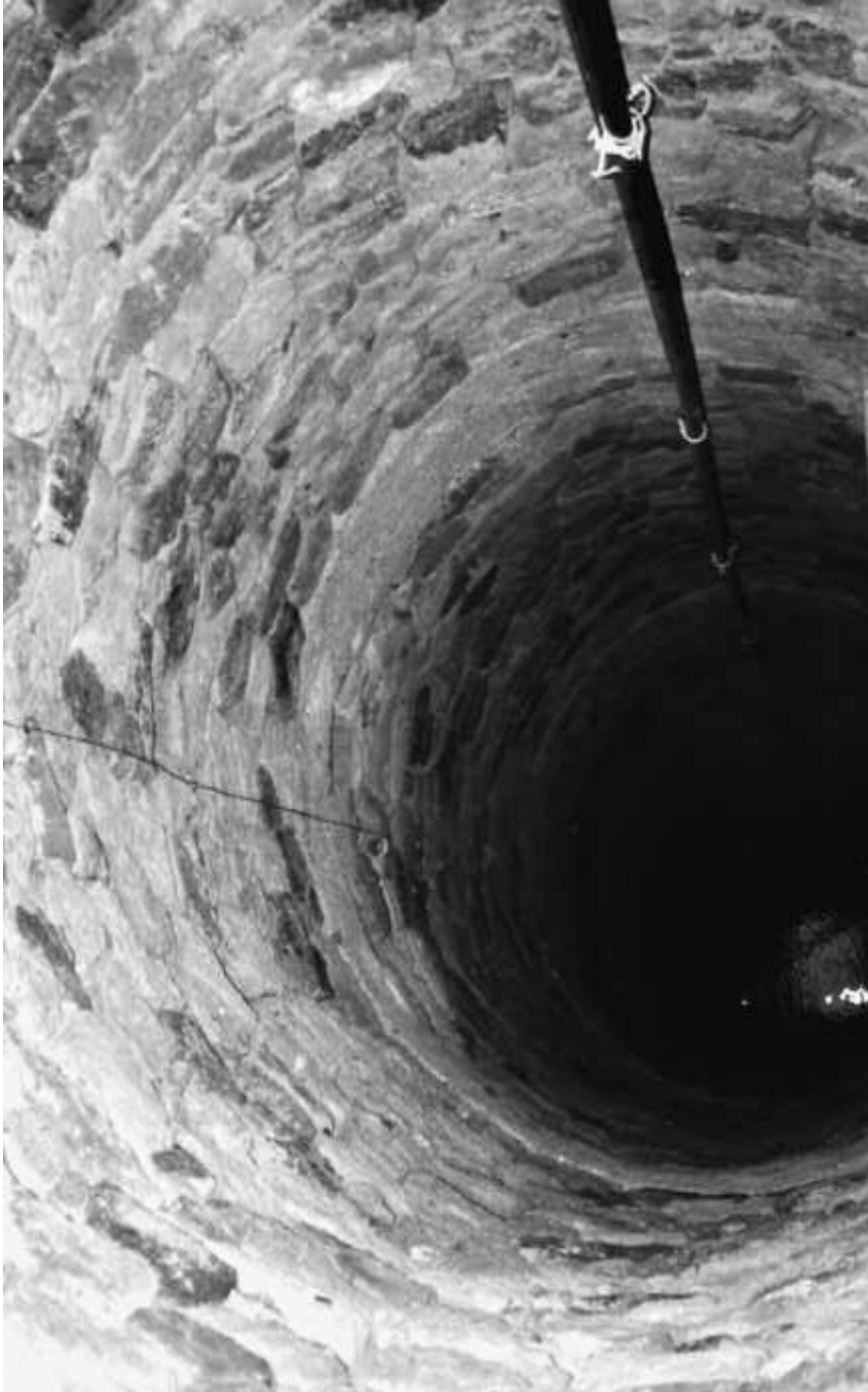
Pozo en el Oeste de Gran Canaria.
