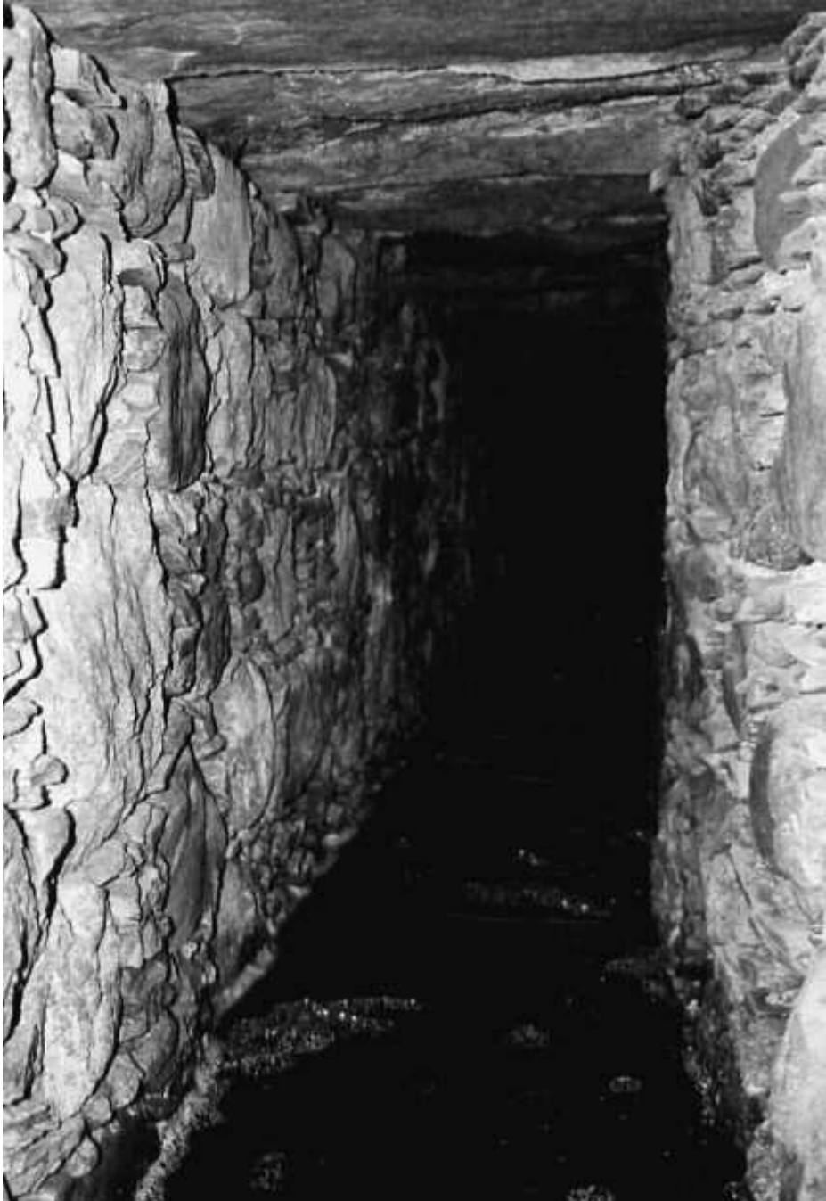
Interior de una mina de agua del Sur de Gran Canaria.
